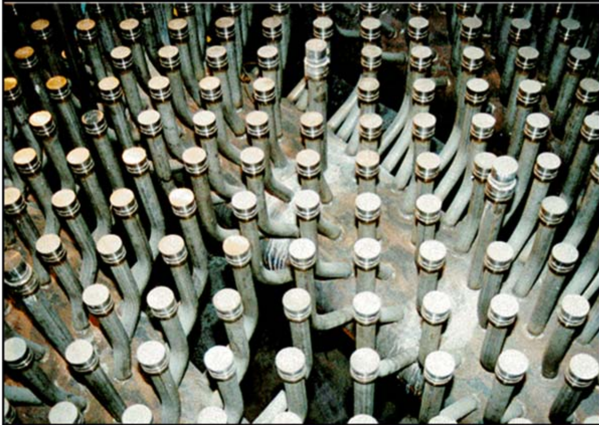
Detalle del lecho fluidizado burbujeante de fondo abierto
